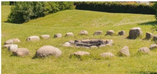
Bålplads med kampesten Siddeegnede (ca. 40 cm) med relativt flad overside, mindre sten til omkransning af bålsted
